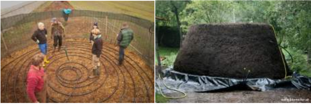
Рис 2 Прокладка труб та готовий біомейлер
